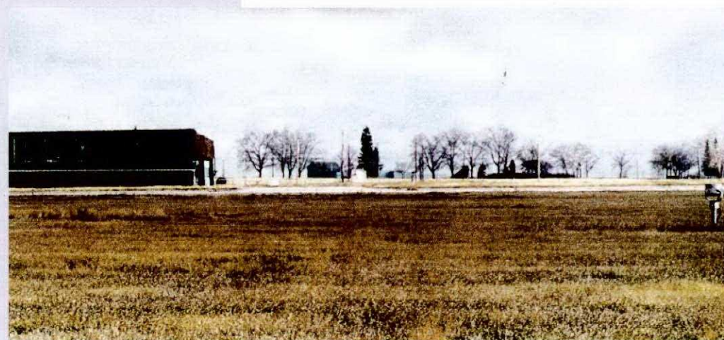
Vue/zone d'approche vers le Hangar 4.
